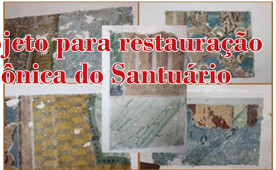
Algumas prospecções realizadas nas paredes internas do Santuário, que revelam a arte que se encontra por trás das várias camadas de tinta
